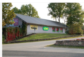
Bauskas iela Nr.16
