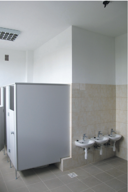
Griķu pamatskolā turpinās WC telpu remontdarbi, savukārt struktūrvienības „Dzirnaviņas” telpās tie jau ir praktiski pabeigti
