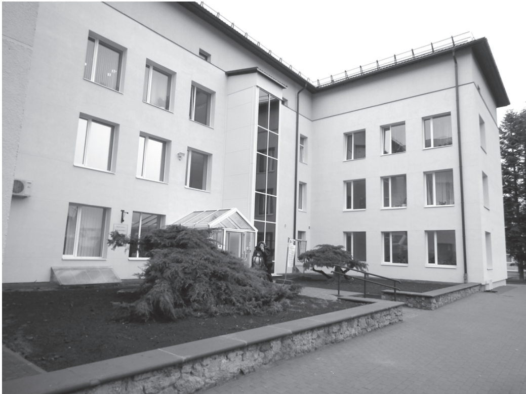
Bauskas poliklīnikas ēka pēc uzlabojumu veikšanas
