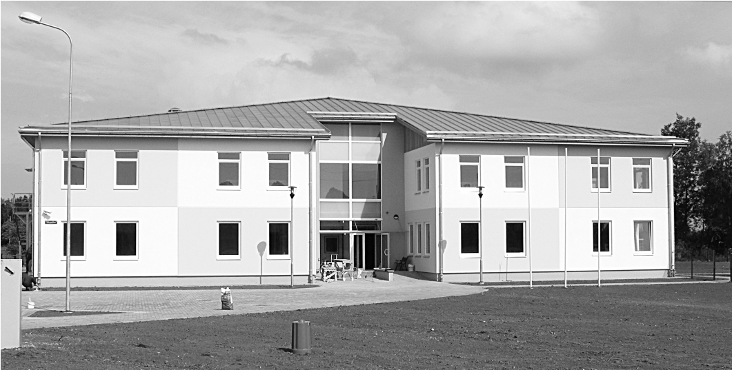
Bērnudārza „Mārpukīte” ēkas būvniecību veica ģenerāluzņēmējs SIA „Moduls Rīga” - viens no vadošajiem būvniecības uzņēmumiem Latvijā. /Foto: L.Ārente/
