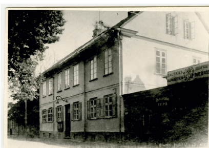
Pilsētas valdes nams un bibliotēka ap 1930. gadu. Blakus vienstāva būve ar izkārti "Bauskas Brīvprātīgo ugunsdzēsēju biedrība".
