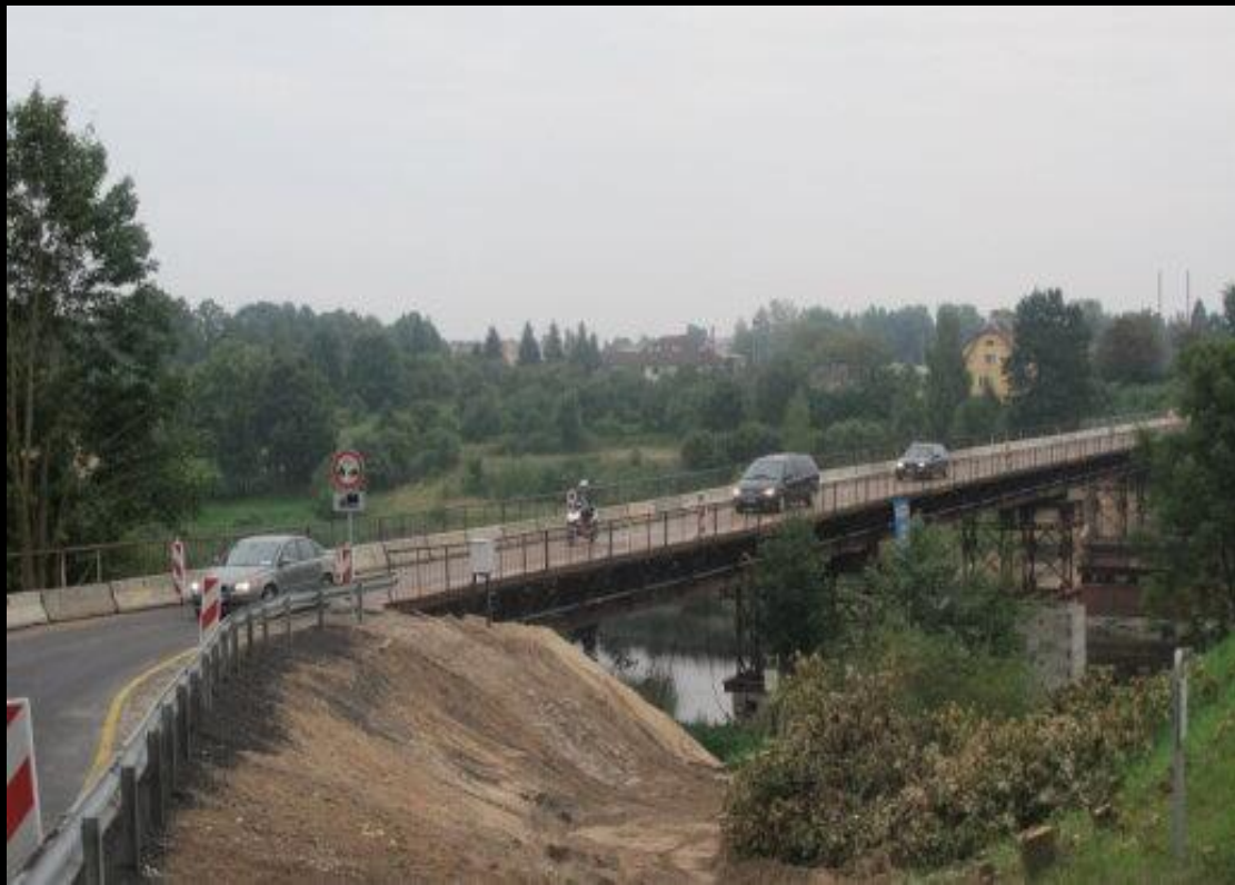
Pagaidu saliekamais tilts tika izmantots Mūsas tilta rekonstrukcijas laikā Bauskā
